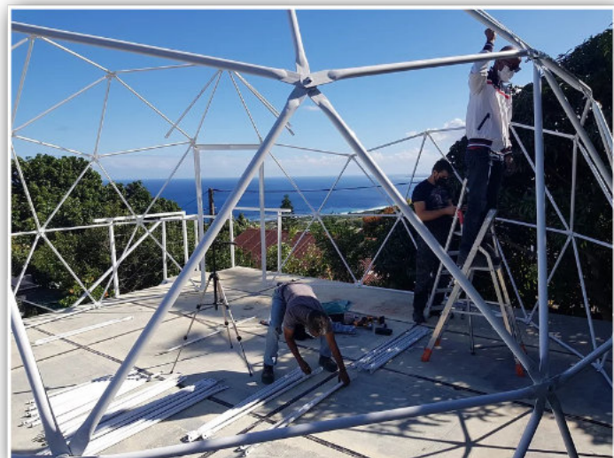
Structure de tubes d'acier galvanisé de haute qualité et thermo-laqués
